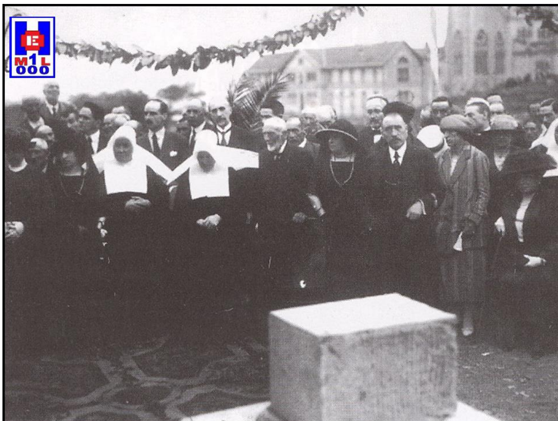
Foto 2 Asilo Reina Victoria. Primera piedra, 1906. Foto cedida Junta del Patronato Zorroaga
